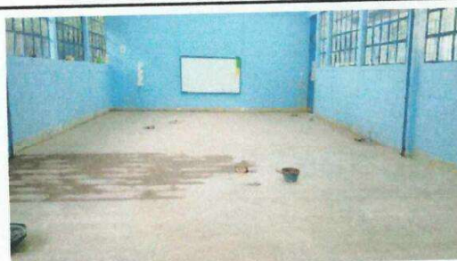
Foto # 6: Sustrucción de piso ceramico
