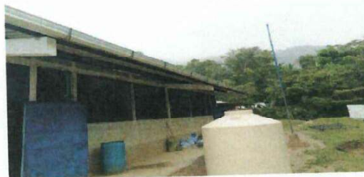
Foto # 2: Sustrucción de canales.
