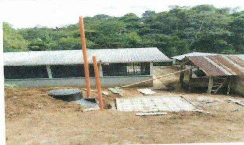
Foto# 2: Instalación de biodigestor para baños.
