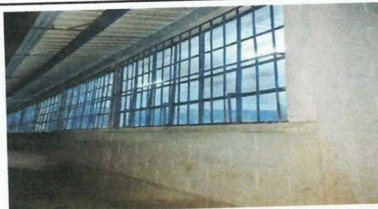
Foto # 4: Sustrucción de balcones.
