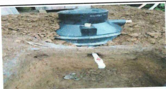
Foto # 5: Sustrucción de biodigestor.
