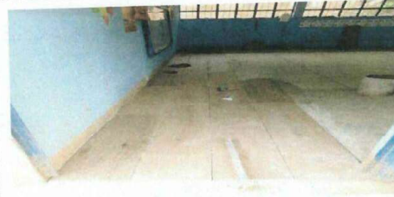
Foto # 6: Sustrucción de piso cerámico
