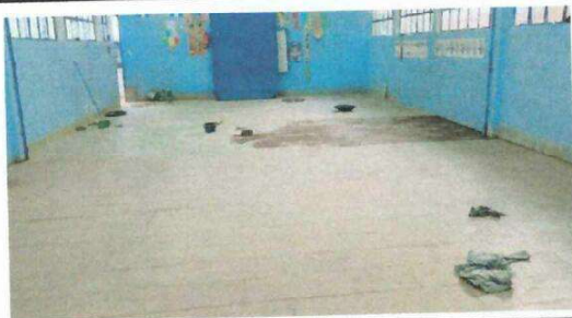
Foto # 5: Sustrucción de piso ceramico
