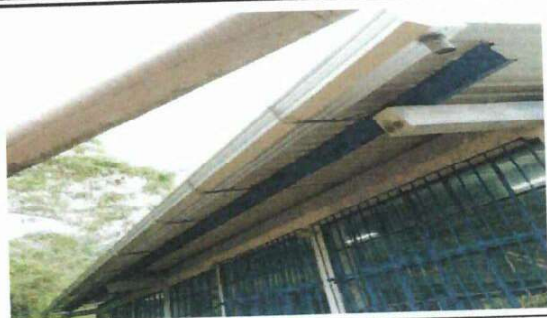
Foto # 1: Sustrucción de canales.
