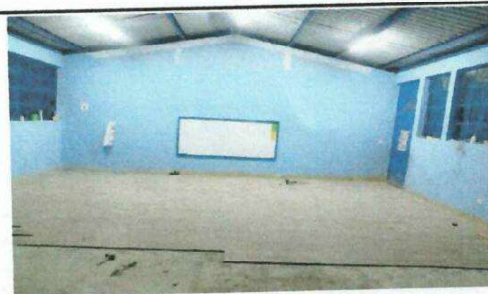
Foto # 4: Sustrucción de piso ceramico
