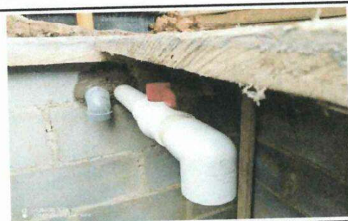
Foto # 3: Sustrucción de caja de líquidos para baños.
