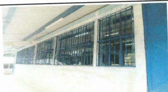
Foto # 3: Sustrucción de balcones.
